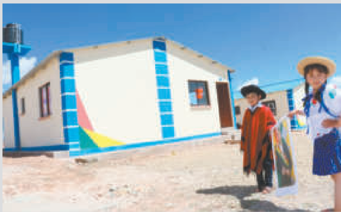
Las viviendas sociales entregadas en Yunchará.
