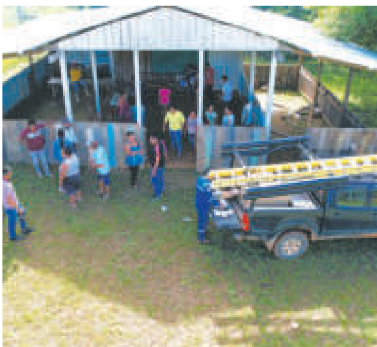
Una vivienda con electricidad, luego de ser afectada por el desborde del río Acre.
