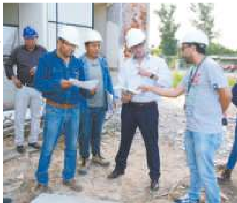
Inspección de la construcción y refacción de la Casa Judicial de Montero.
