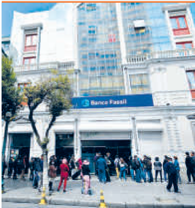
Fachada de Banco Fassil en La Paz.
