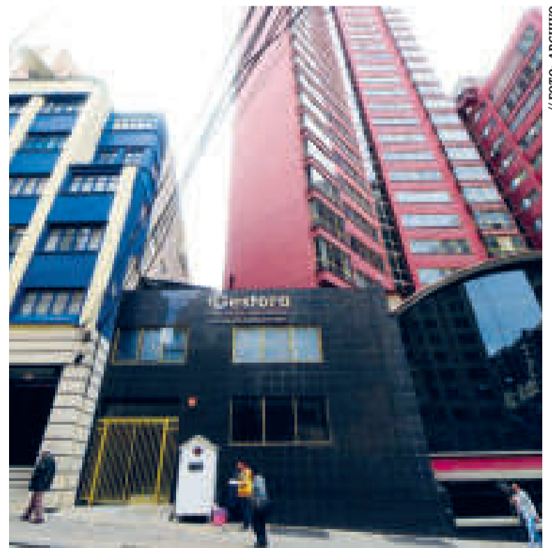
Frontis del edificio de la Gestora Pública.
