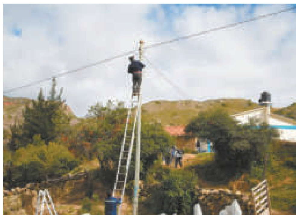
El proyecto de electrificación de Azurduy comprende las ampliaciones de las líneas eléctricas en 40 kilómetros de media tensión, 57 kilómetros de baja tensión y 35 puestos de transformación.
