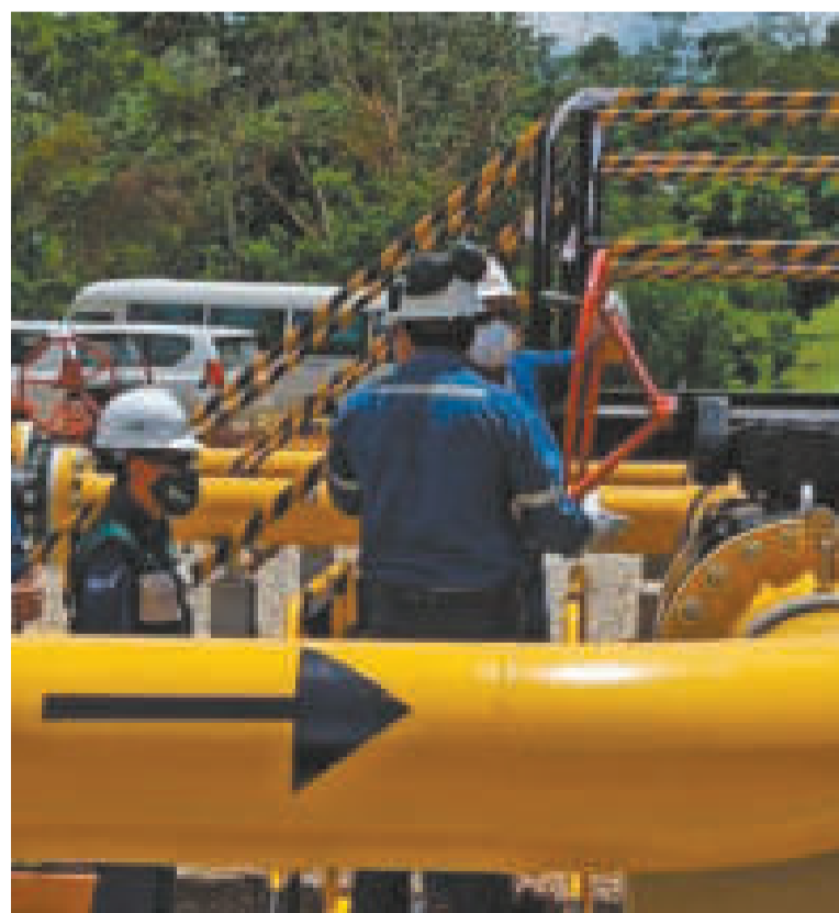
Trabajos en el Gasoducto Sucre-Potosí fase II.
