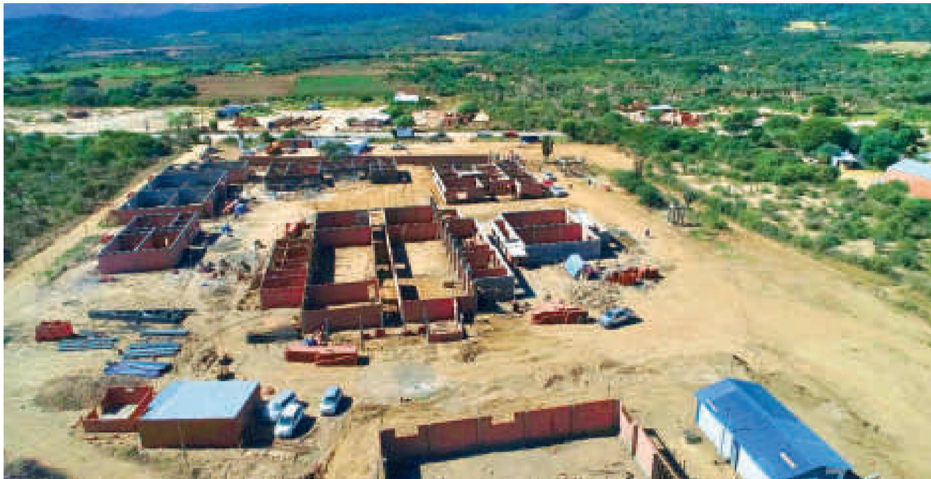
Construcción de una planta industrial de bioinsumos, fertilizantes líquidos y abonos orgánicos en Pampa Grande, Santa Cruz.
