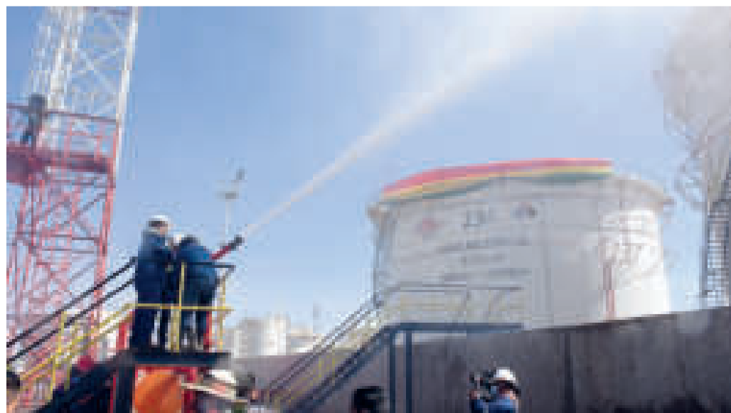
El proyecto de Incremento a la Capacidad de Almacenaje (ICA), en la planta de Senkata.
