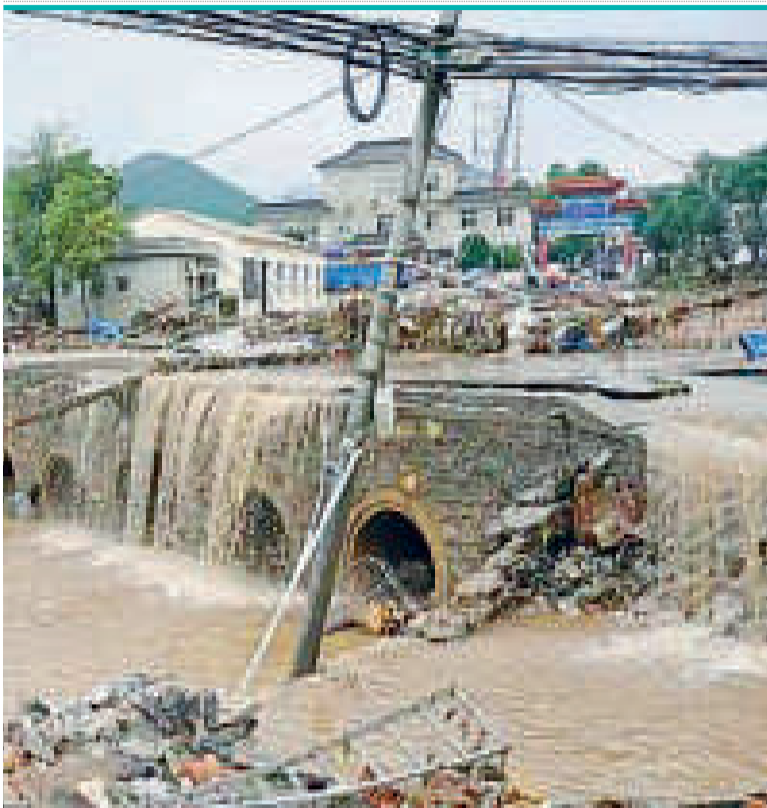
Calles inundadas luego de una torrencial lluvia.
