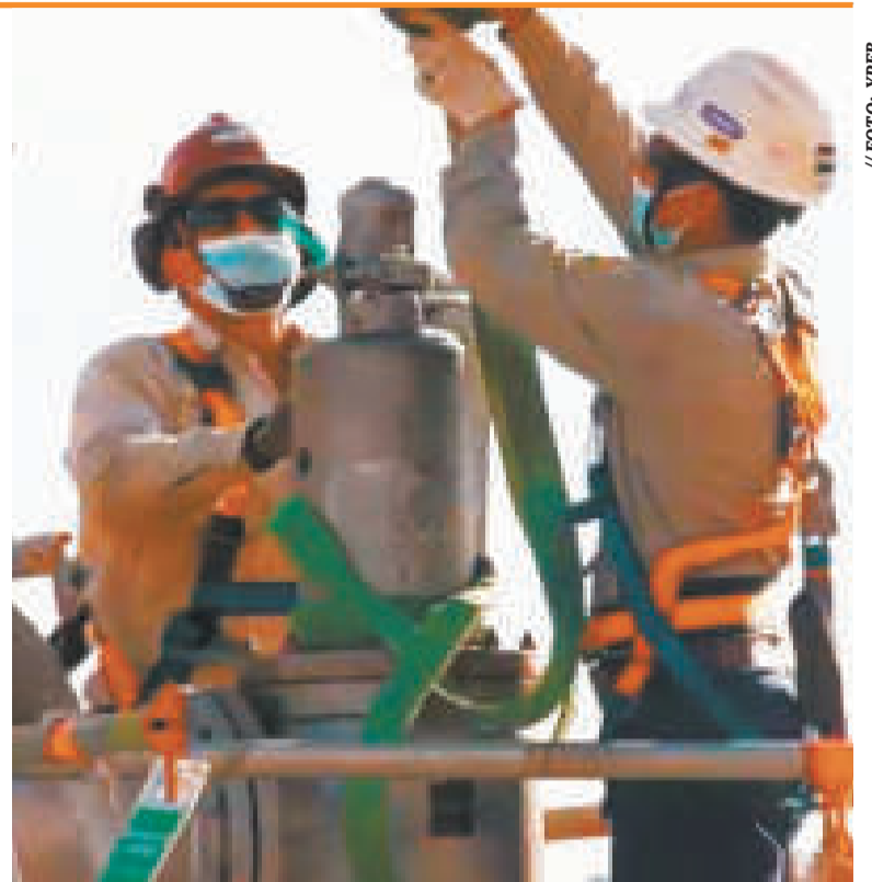
Trabajos de mantenimiento en la Planta de Amoniac y Urea en Bulobulo.
