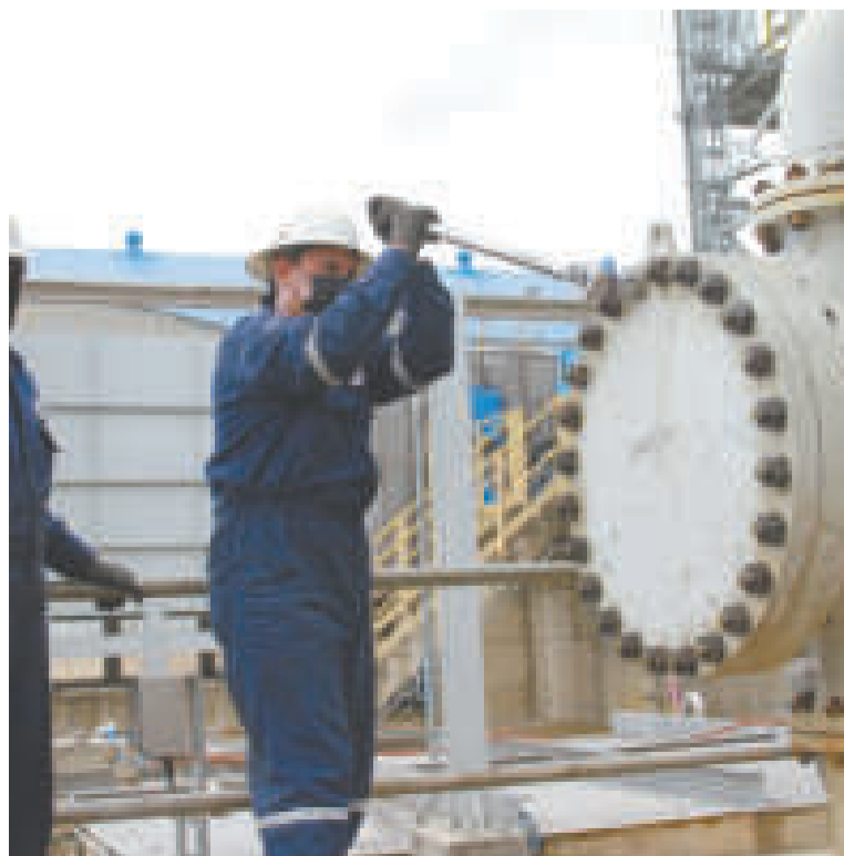
Trabajos en la Planta de Amoniaco y Urea.
