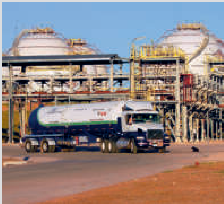
Vista de la planta Carlos Villegas, ubicada en Tarija.
