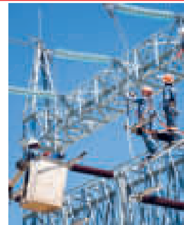
Trabajos del personal de Elfec.
