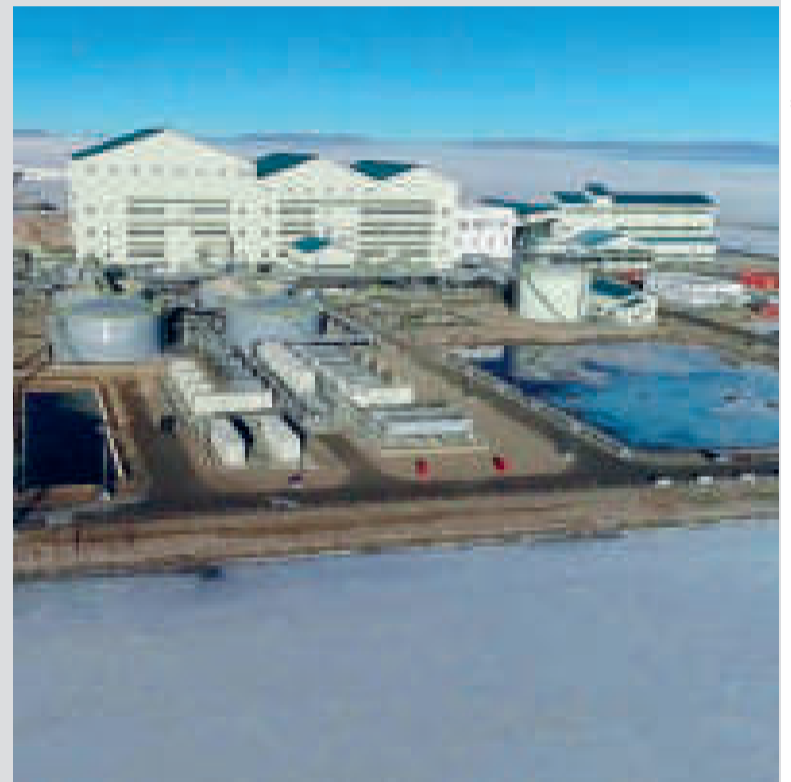
La Planta de Carbonato de Litio de YLB, en la localidad de Llipi, Potosí.
