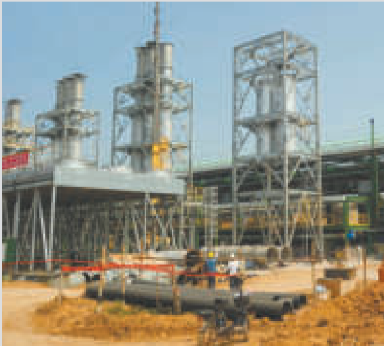
Construcción del Complejo Siderúrgico del Mutún en Puerto Suárez.
