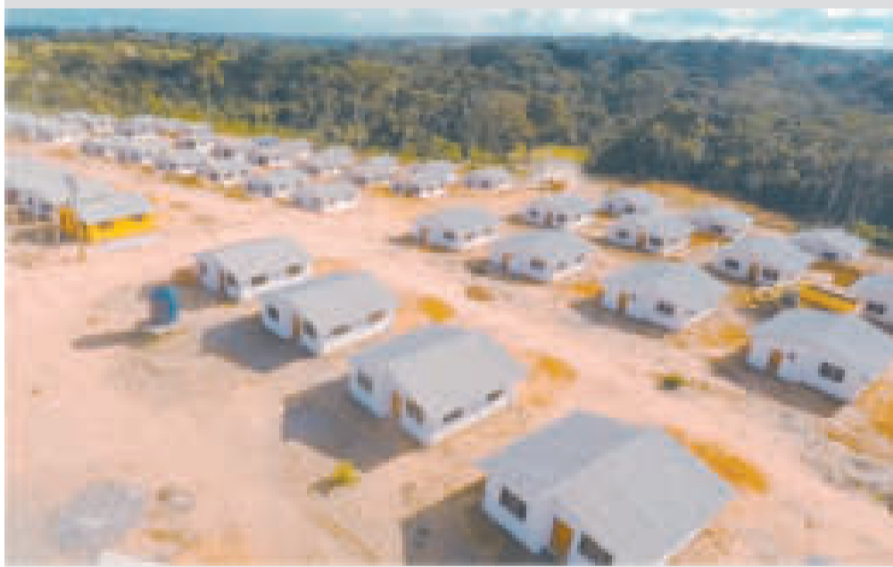
Viviendas edificadas en el departamento de Pando.
