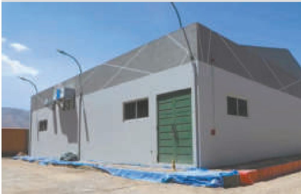
Edificación de la planta de procesamiento de la hoja de coca.
