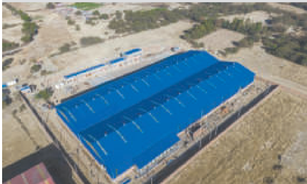
La planta de fertilizantes NPK está ubicada en el Parque Industrial Santiviáñez, Cochabamba.
