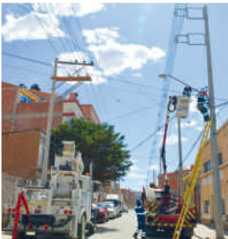
Los trabajos de ENDE en la ciudad de Oruro.
