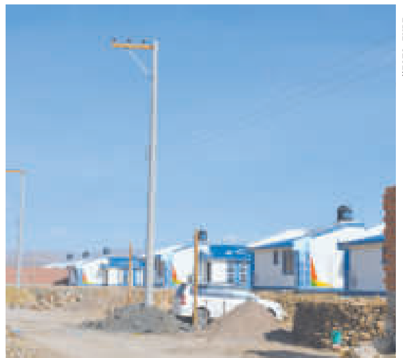
La red eléctrica construida por ENDE, en Oruro.
