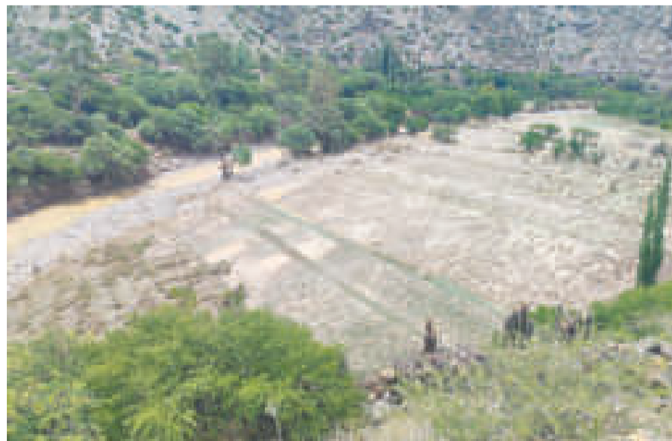
Los daños causados por la riada en Cotagaita.
