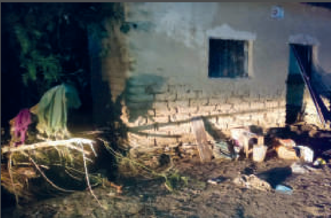
Una de las viviendas afectadas por la riada en Cotagaita.
