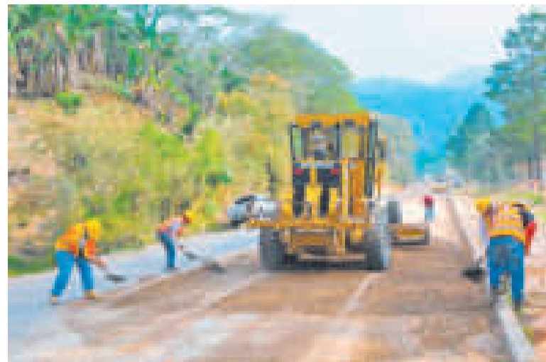
Las obras que se hicieron fueron la conformación del terraplén terminado y reposición de ripio chancado.
