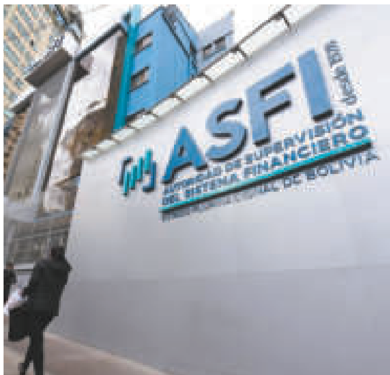
Frontis del edificio de la ASFI.
