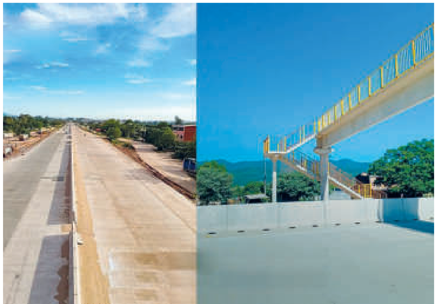
Parte de las obras ya concluidas de la doble vía.
