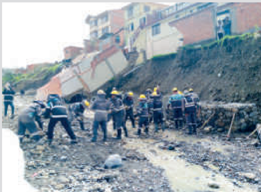
Colapso de una vivienda en la zona Irpavi II.
