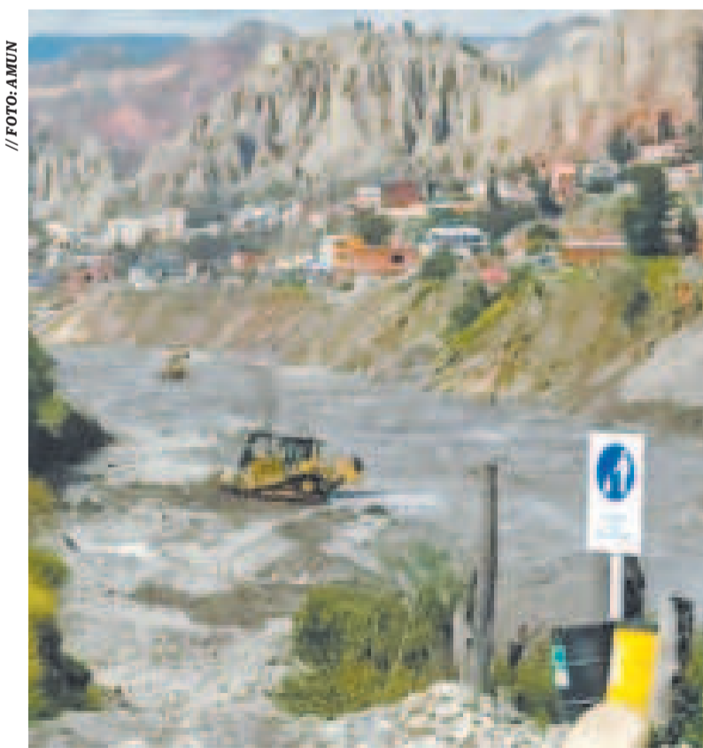
Maquinaria trabaja en el río Irpavi para evitar desbordes.
