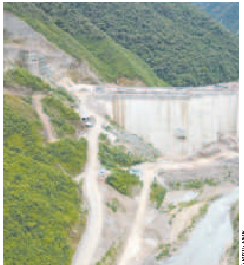
La presa alcanzó una altura de 88,52 metros y ENDE continuará su construcción.
