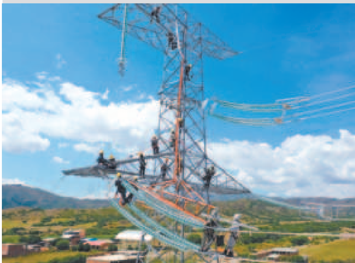
Personal de la estatal ENDE en trabajos de instalación de antenas de electricidad.
