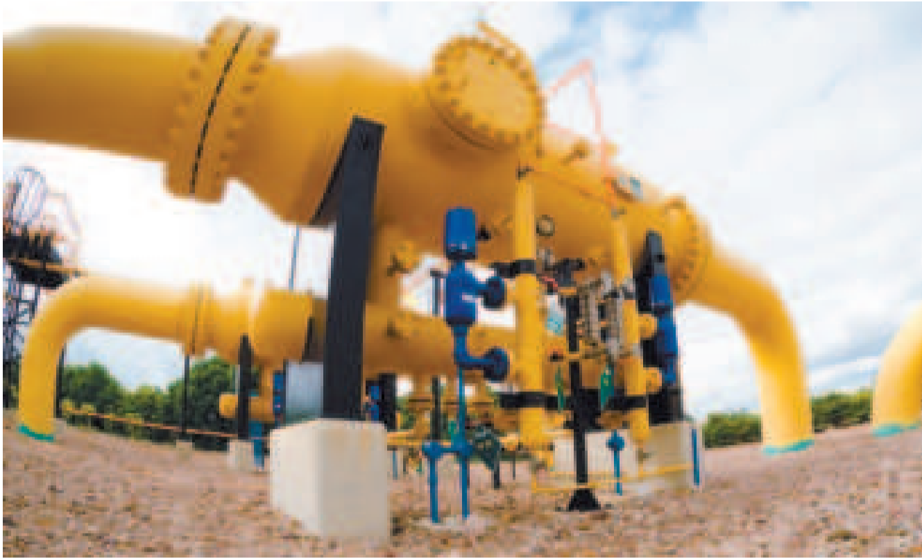
Parte de los ductos de gas por donde pasará el combustible para el complejo siderúrgico del Mutún.
