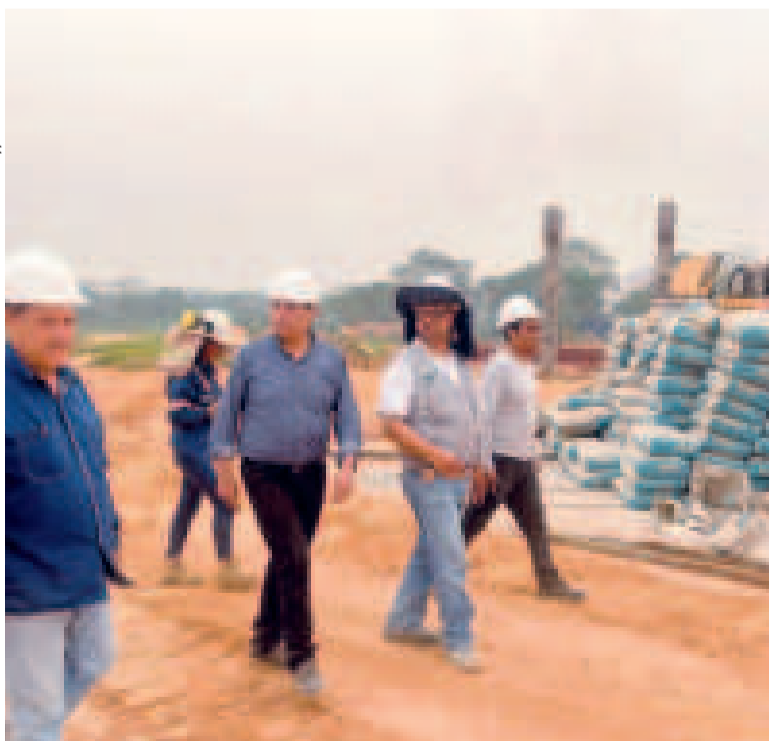
El gerente de Emapa, Franklin Flores, inspecciona la edificación de la planta.
