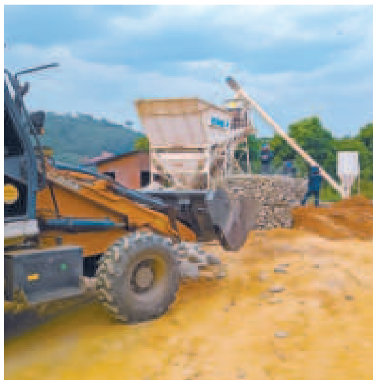
Los trabajos de perforación que inició la ABC.
