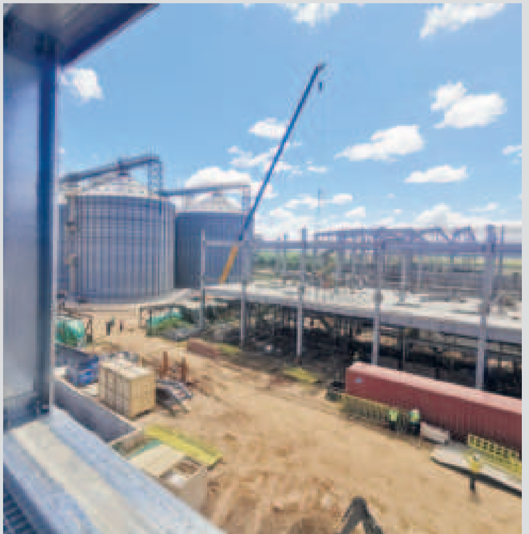
La construcción de la factoría de subproductos de soya.
