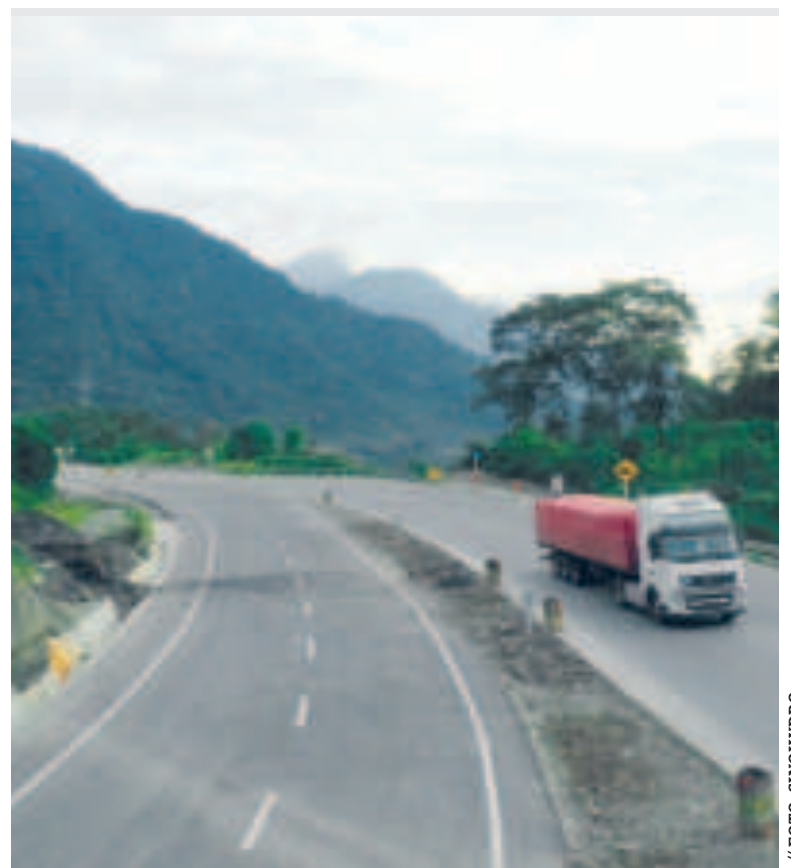
Una parte de la carretera ya concluida.
