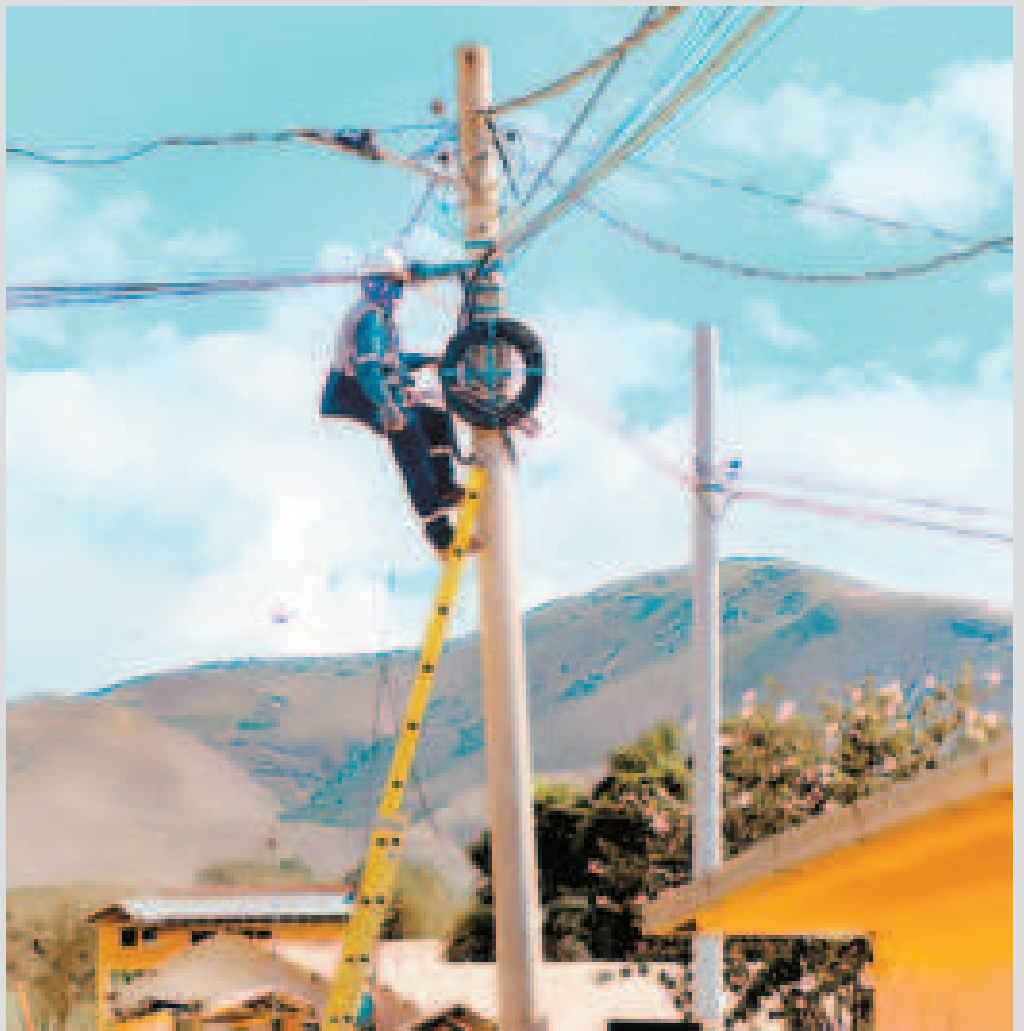
Los trabajos de interconexión de fibra óptica que hace Entel.
