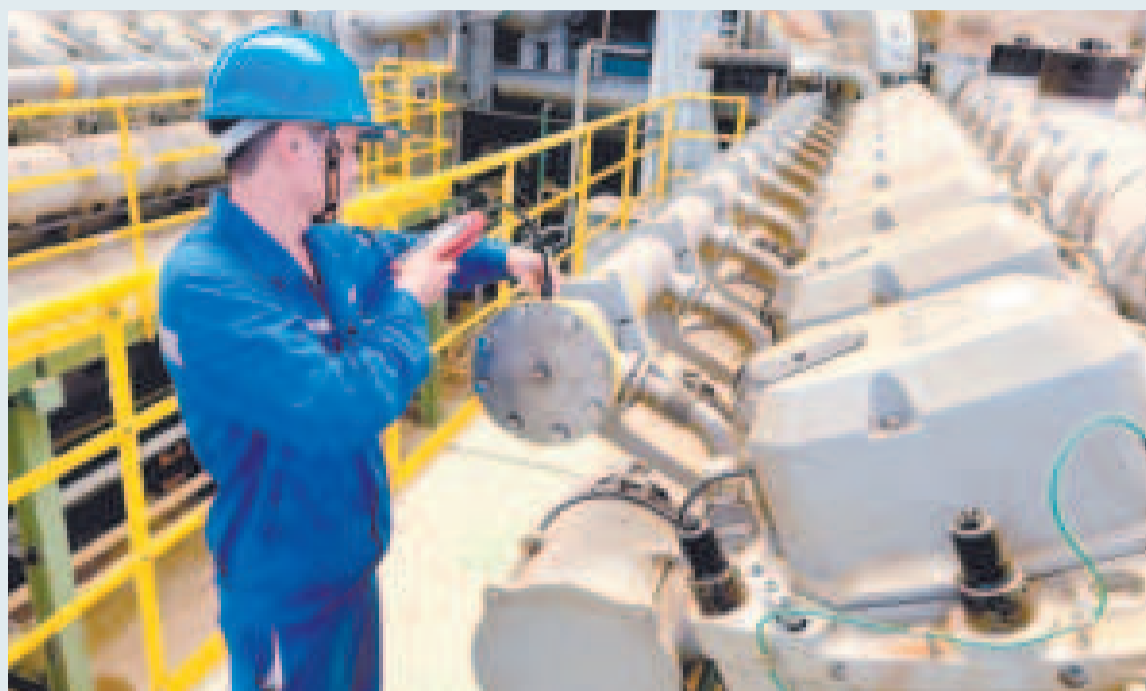
La medición del funcionamiento de equipos.
