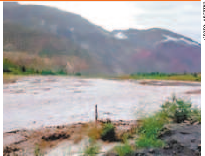
Riada que afectó al municipio de Luribay.
