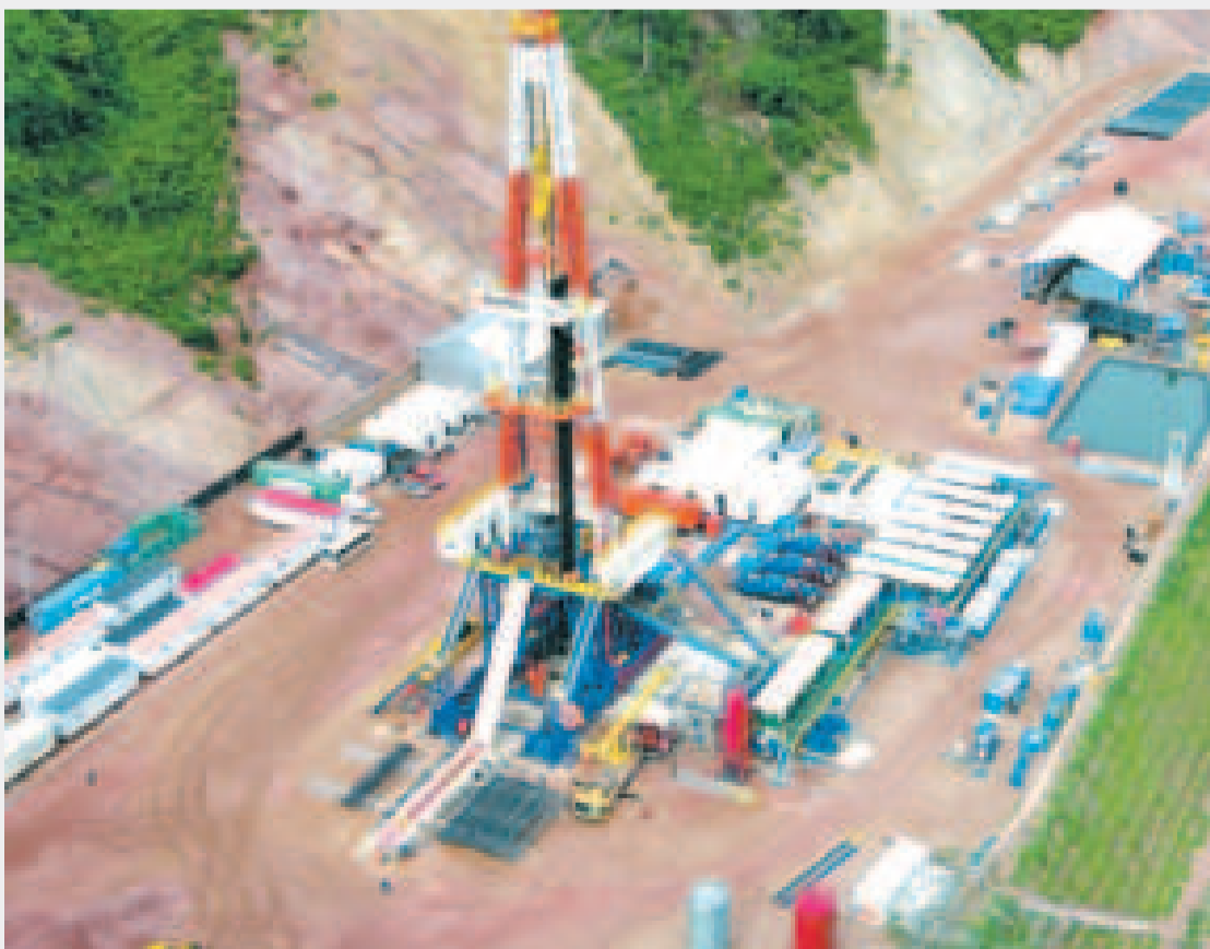
El área de intervención del pozo Iñau, en Chuquisaca.
