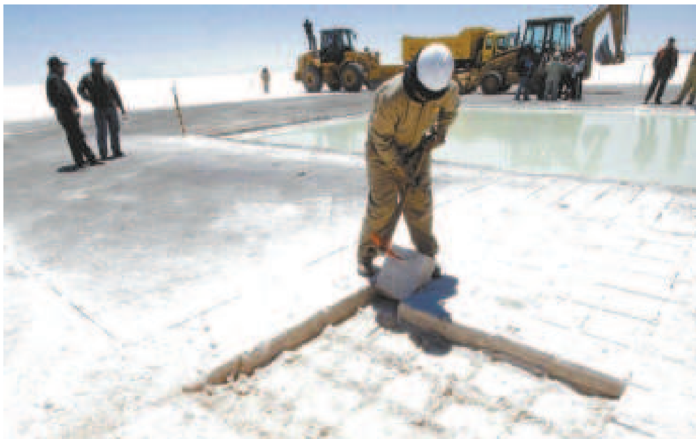
Trabajos para la industria del litio en el salar de Uyuni.
