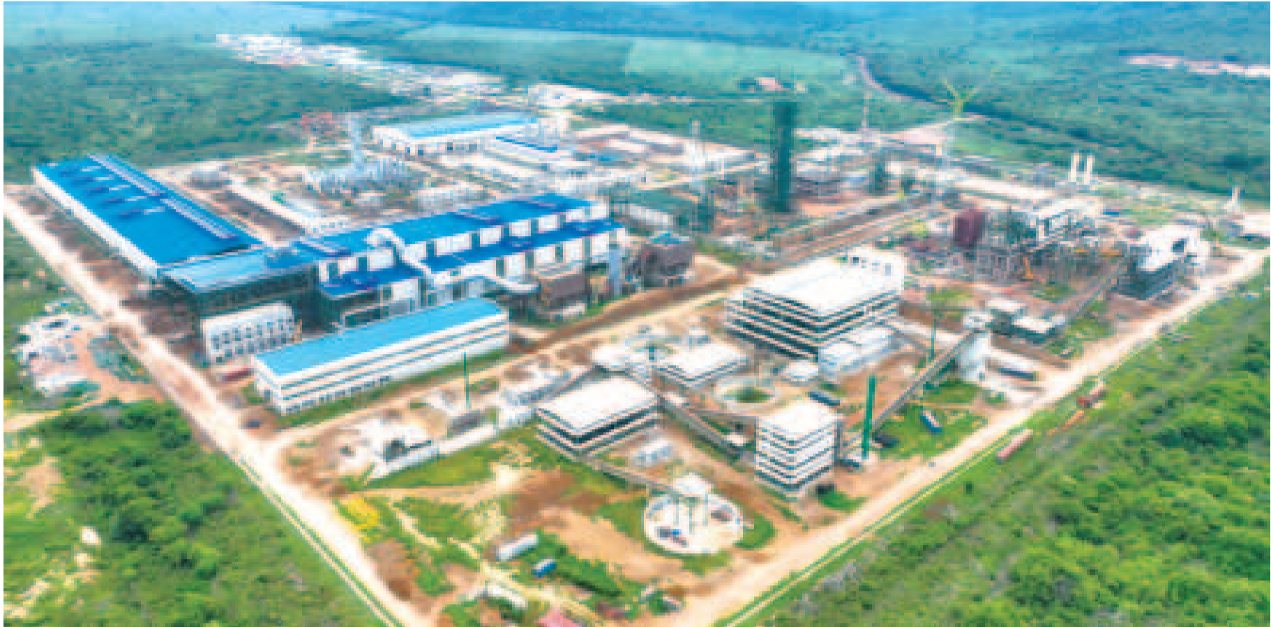
La edificación del complejo siderúrgico del Mutún, en Santa Cruz, registra un importante avance.
