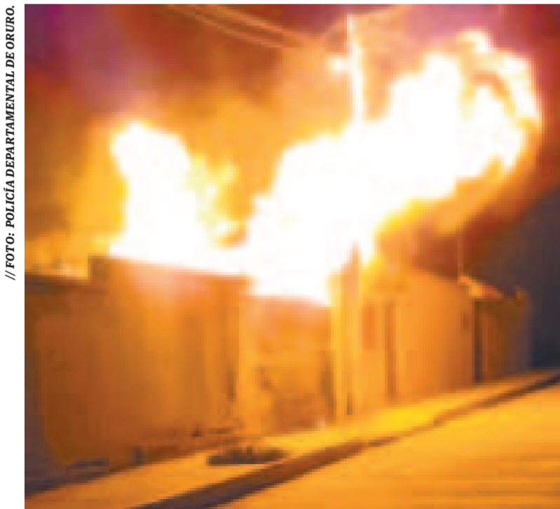
Incendio registrado en un taller de transformadores.
