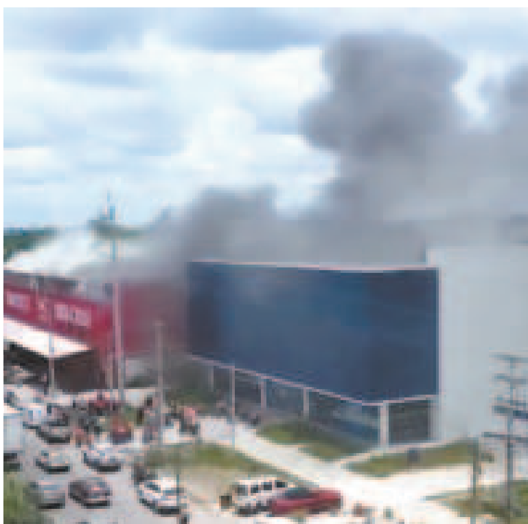
El incendio consumió la infraestructura de la empresa importadora Dialcruz.
