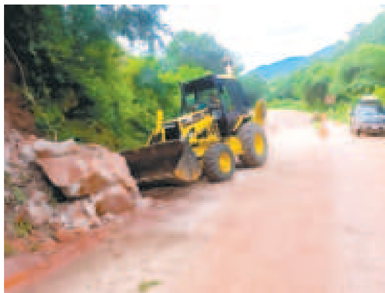
Las tareas de limpieza y mantenimiento de carreteras.
