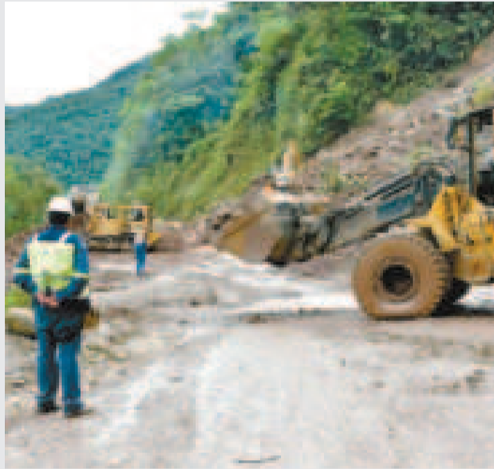
Mantenimiento de las carreteras en las vías paceñas.
