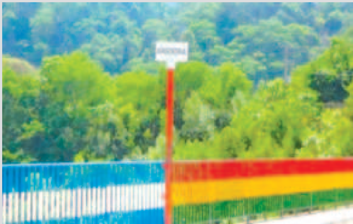
Puente fronterizo entre Bolivia y Argentina.
