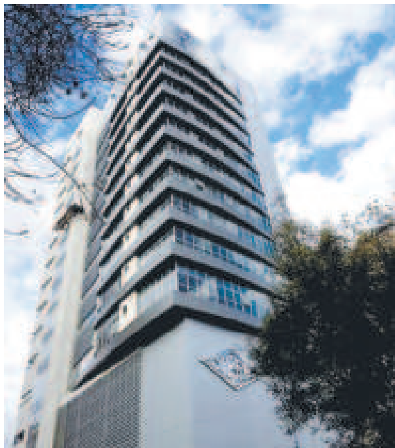
El frontis del edificio de YPFB en La Paz.
