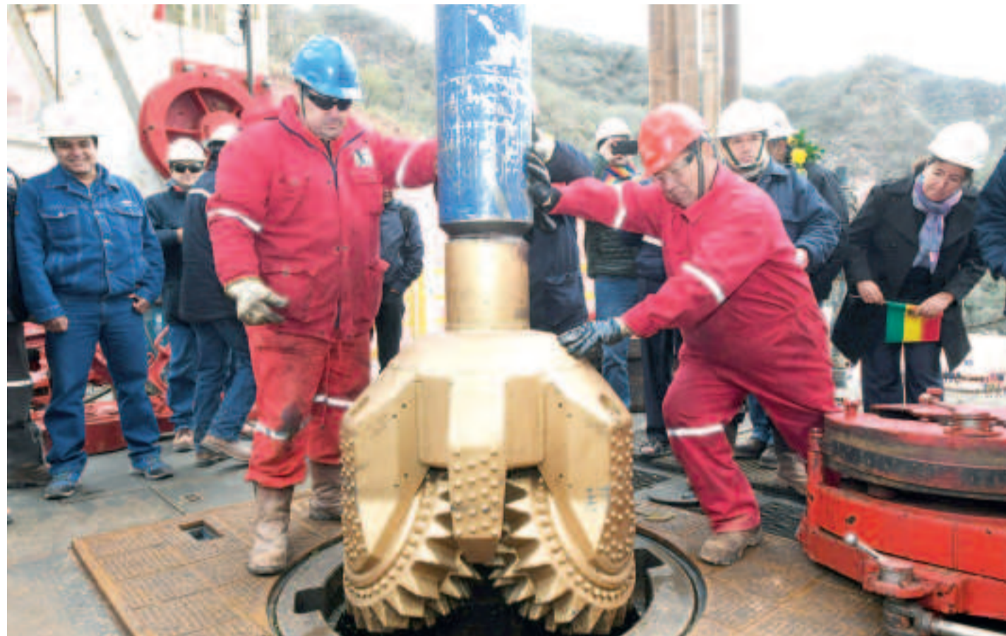
Trabajos de perforación en un pozo hidrocarburífero exploratorio.
