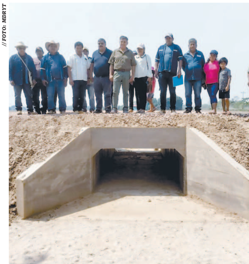
Una de las alcantarillas inauguradas.
