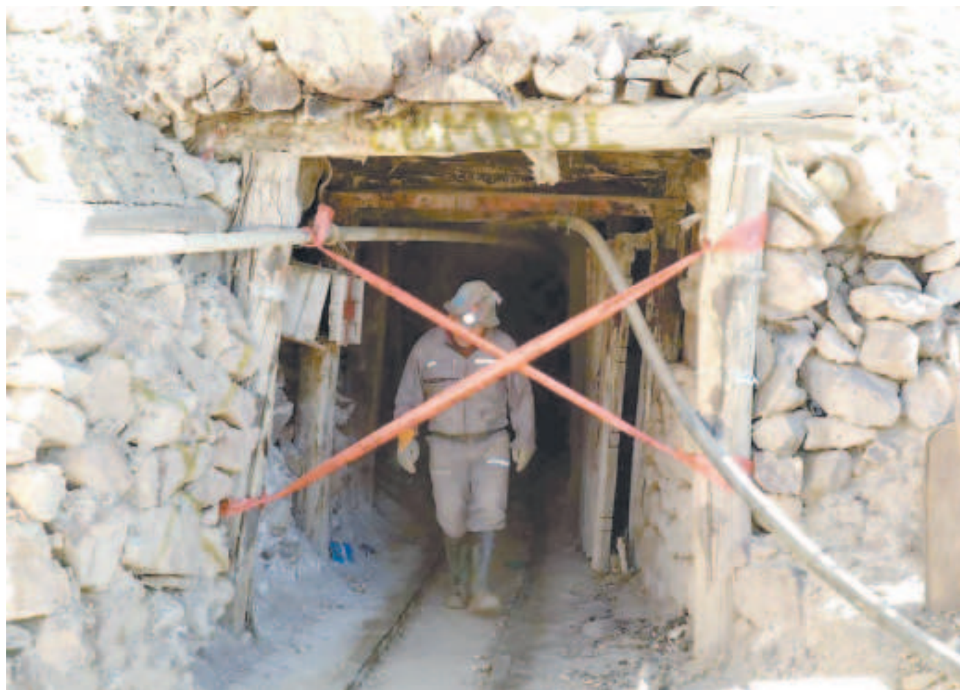
Una de las bocaminas cerradas sobre la cota 4.400 del cerro.
