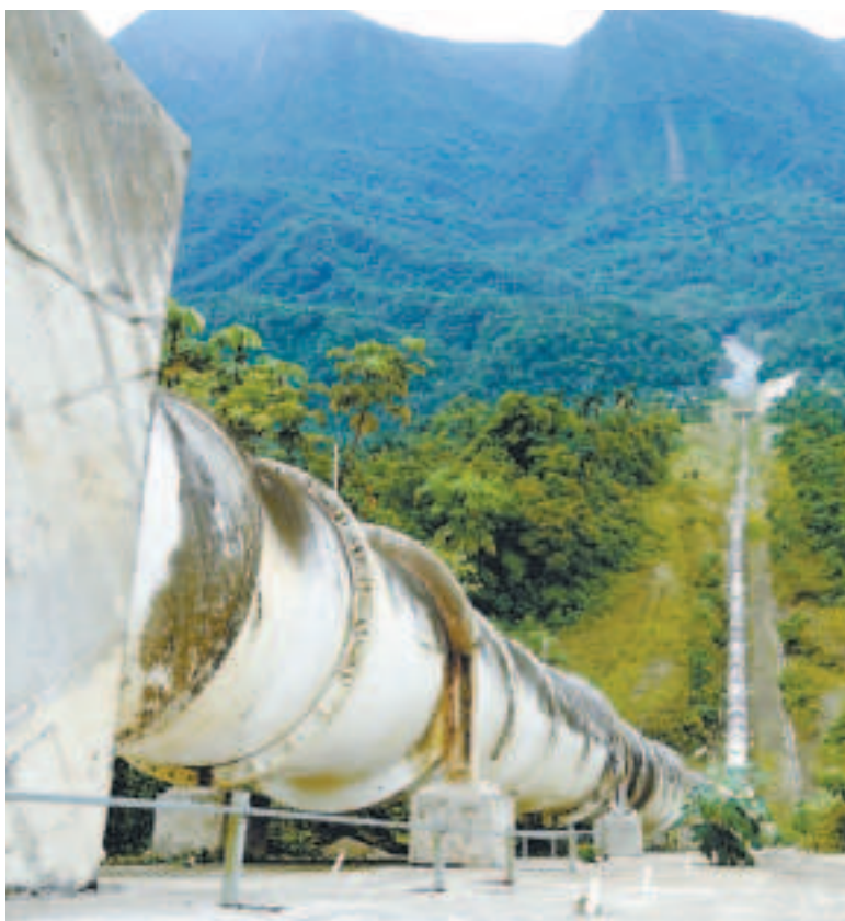
Uno de los túneles que conforman el Grupo 2 del proyecto.
