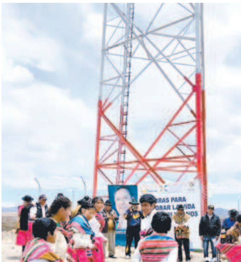
La antena de telecomunicaciones entregada.
