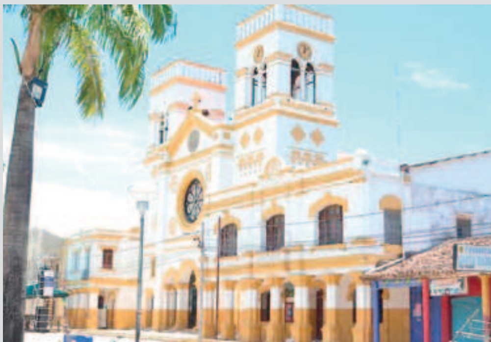
Una vista de la iglesia de Trinidad, ciudad parte de la carretera que ahora integra la Red Vial Fundamental.
