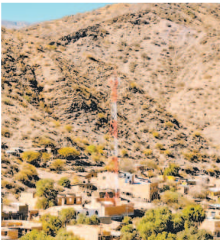
Una radiobase de telecomunicaciones de Entel.
